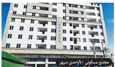
مجتمع مسکونی ۹۰ واحدی سپهر
